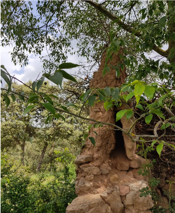
Restos del mur de tàpia de la planta alta. La pedra afegida a la dreta no és al seu lloc.
