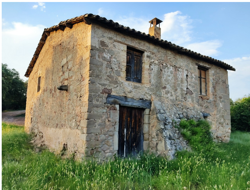
Façana de l'edifici actual
