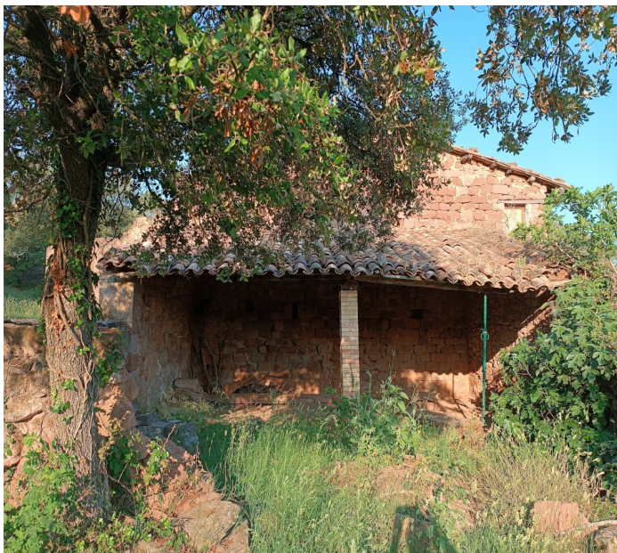
Lliça de la Peça, Sant Feliu Sasserra. Es poden apreciar les tanques laterals i un fragment de la central, parcialment derruïda. El cobert es obert gràcies a un pilar central
