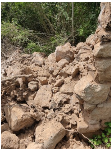
Ensorrament de mur de pedres amb morter de garsa per filtracions. Cal Burgès , Lluçà
