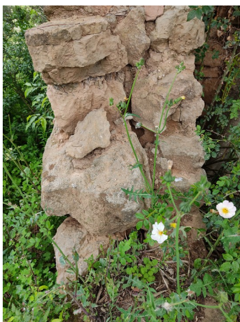
Mur de la planta baixa, de pedra borda amb morter de garsa . Maig 2023
